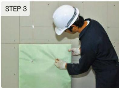
ติด Spindle Pin ตามระยะที่กำหนดไว้แล้วจนครบทุกจุด และทิ้งไว้ให้การแห้งเพื่อรับน้ำหนักได้เต็มที่
