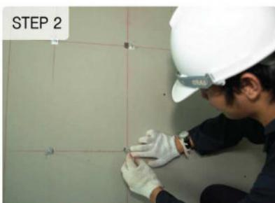
ทำการติดตั้ง Spindle Pin ด้วยการชนิดพิเศษ ในกรณีที่เป็นผนังยิบชิ่ม หรือผนังไม้สามารถยึดด้วยวิธีตอกตะปุ่นได้
