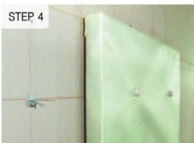
ติดตั้ง วัสดุอะครูลิก เอสซีจี สำหรับผนังดูดซับเสียง Cylence Zoftone™ กับ Spindle Pin โดยเลี่ยบให้หลุดแผ่น โดยมีรูปแบบการของหัวติดตั้งหัวหมุดทั้งสิ้น 2 แบบ
