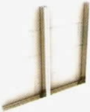
1. ติดตั้งโครงคร่าวบนผนังคอนกรีต
